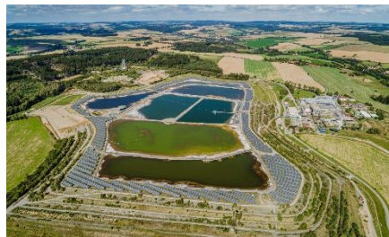
Fotovoltaická elektrárna Rožná
