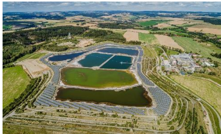
Fotovoltaická elektrárna Rožná
